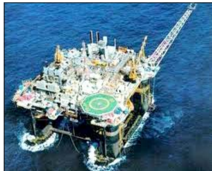
» Plataforma P-32, situada na Bacia de Campos, no Rio de Janeiro. A Petrobras vai dobrar de tamanho
