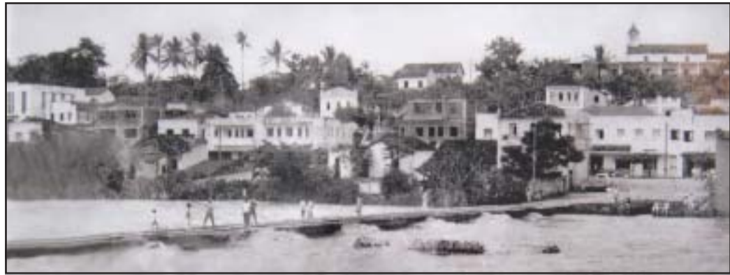
» A antiga ponte de madeira, (cujos pilares resistem até hoje), em uma das maiores enchentes já registradas em Nova Venécia, nos anos 60
